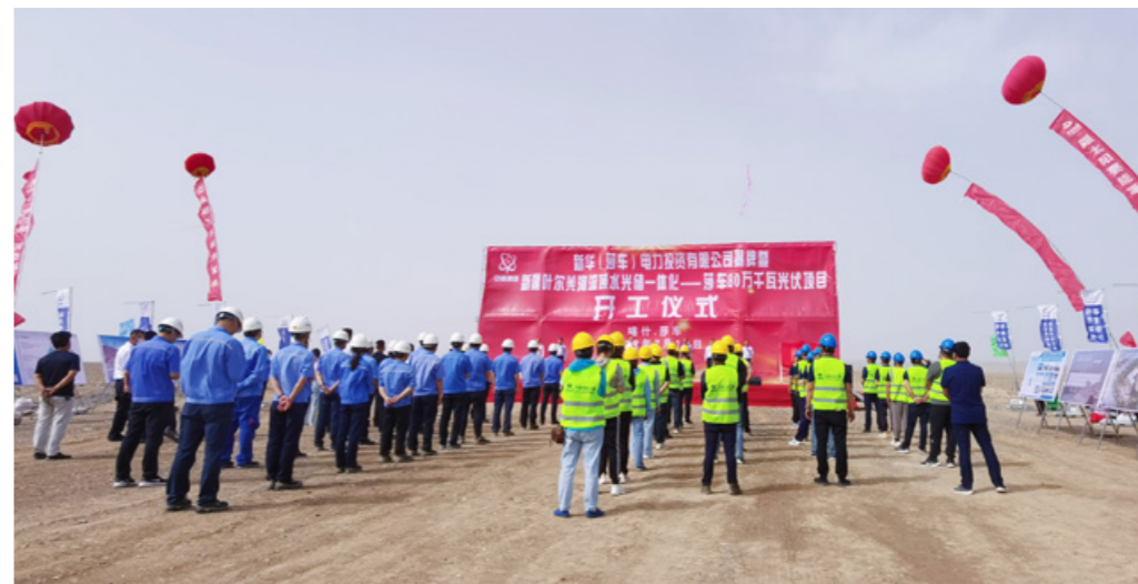
莎车 80 万 kW 光伏项目开工仪式
