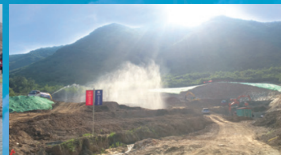
河南五岳抽蓄电站开展洒水降尘、湿法作业
