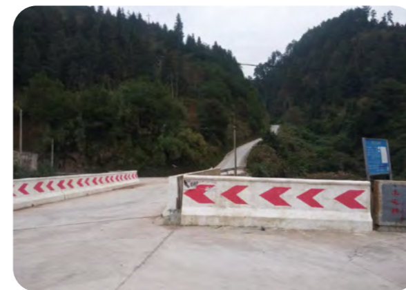
2020年，完成危桥改造工程。
