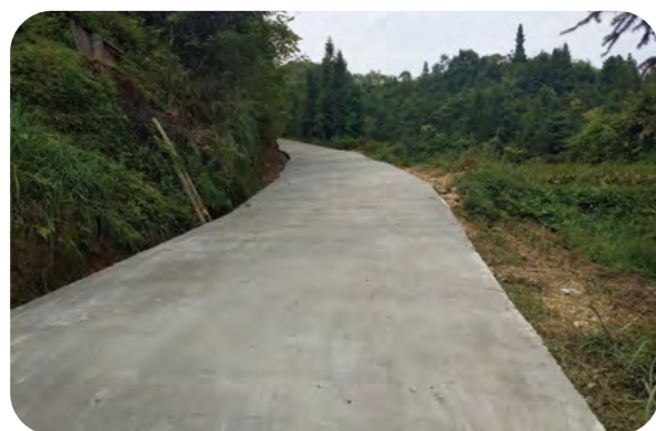
通组道路硬化后
